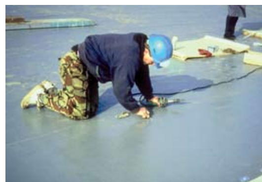
fig. 2: Contrôle des soudures
